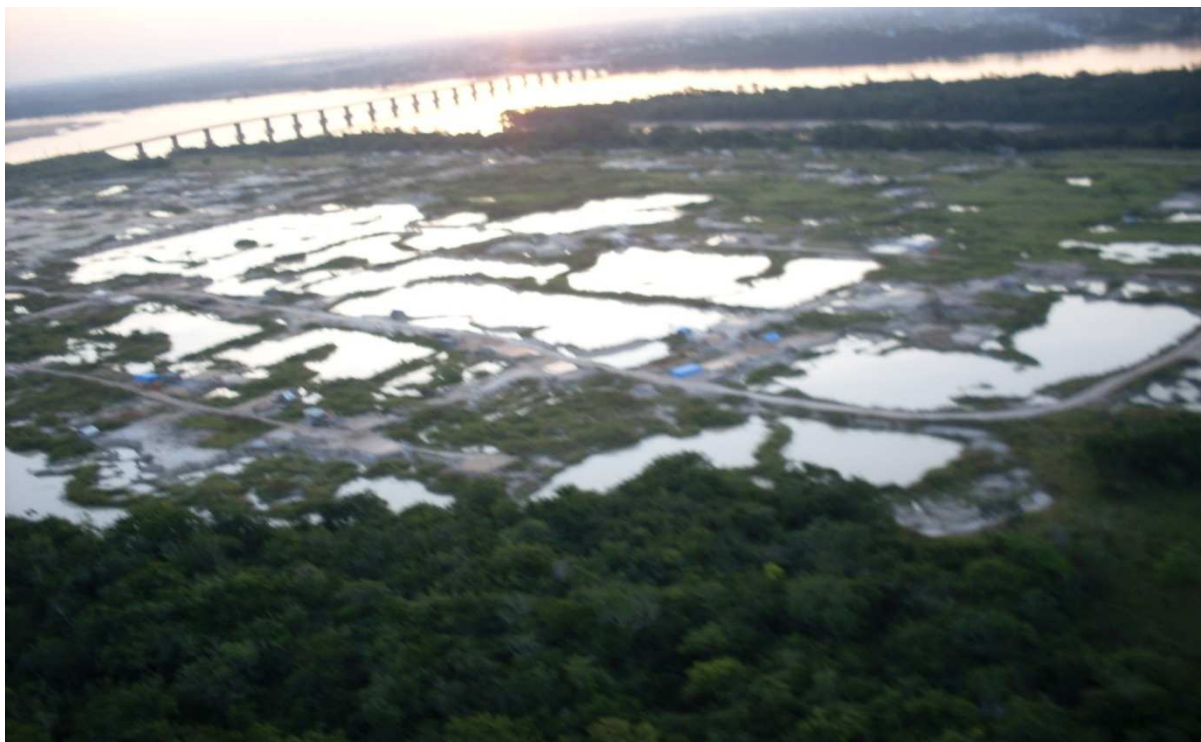
Figura 3 - A Exploração de Argila e os impactos ambientais na margem esquerda do Rio Branco em 2009 (Foto: Autora Márcia Falção)
