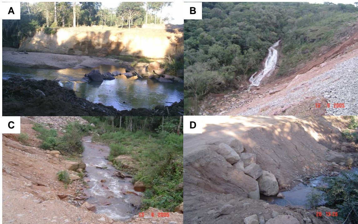
Figura 11 - Imagens da erosão e assoreamentos nos recursos hídricos.
