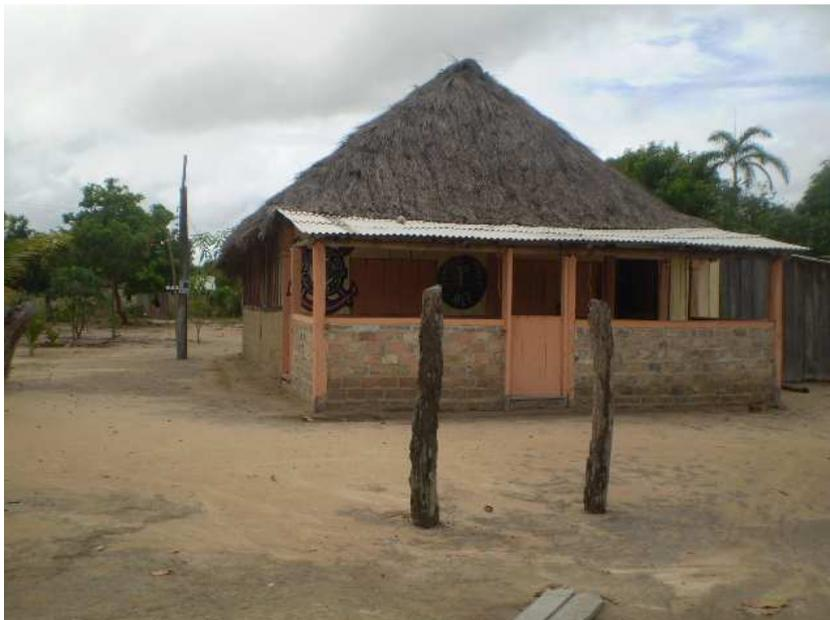
**Figura 27 - Unidade familiar com parte da parede construída em alvenaria e parte da cobertura com telha brasilite.**
