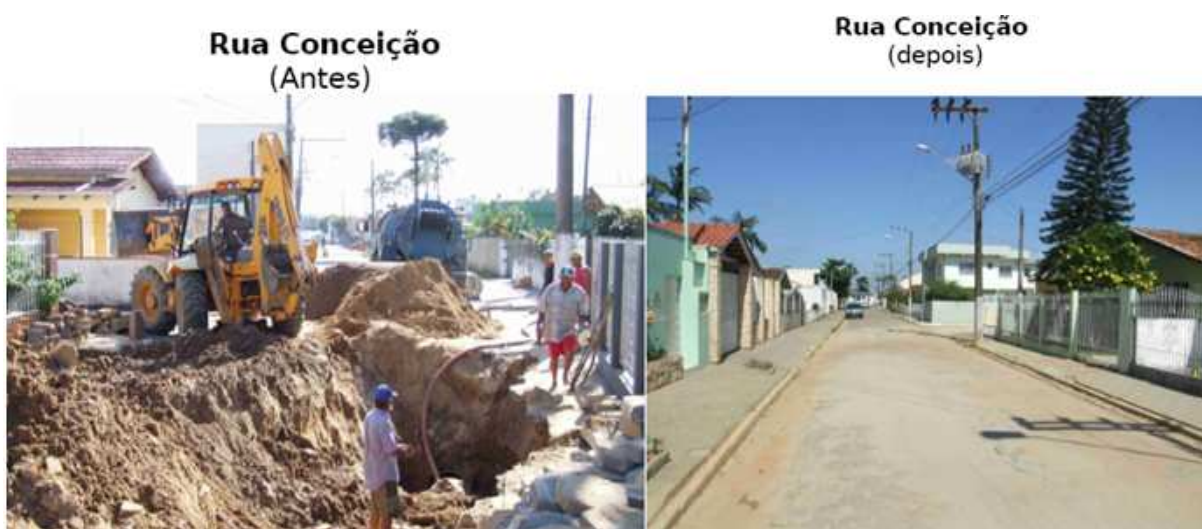
Figura 2: Serviço de drenagem - Rua Conceição - Comparação antes e depois da drenagem
