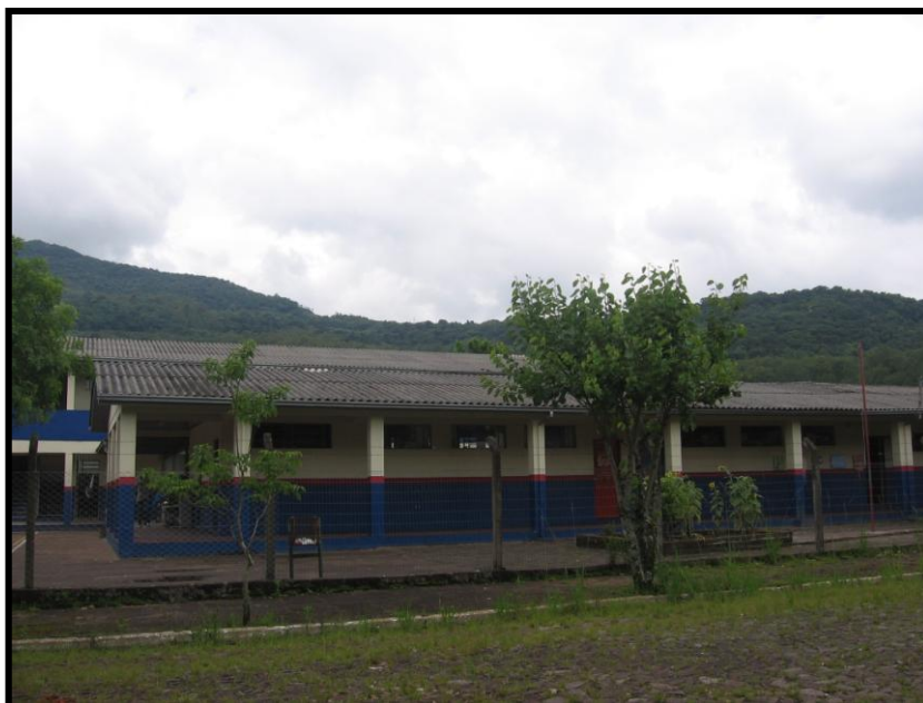
Figura 06: registro da fachada principal da escola Bairro Moinho Fonte: Beibi D. Lamb, 2010
