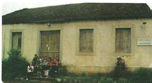
Durante a saída de campo, os alunos e a professora Kátia visitaram a Casa de Pedra, primeira casa de alvenaria da região, local que marca o início da colonização alemã do município.
