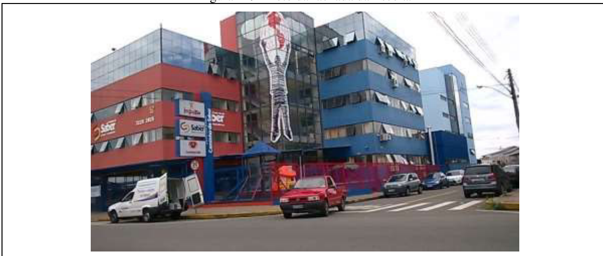
Figura 149 - Foto da fachada da Escola.
