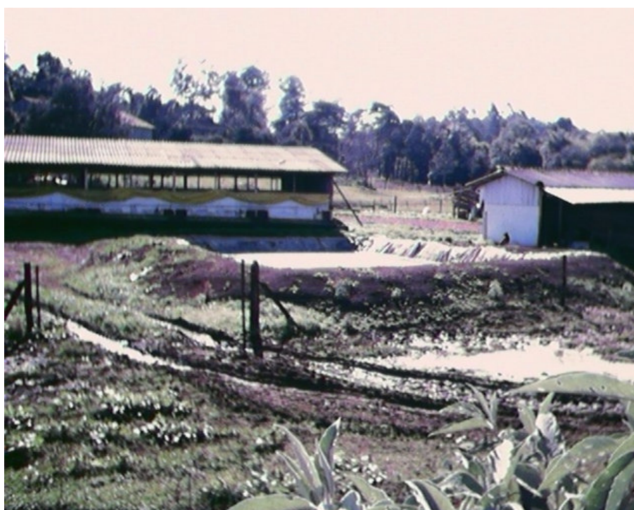
FIGURA 22 - Estrumeiras que, com a ação da chuva, transbordaram e destinaram-se ao leito do rio.
