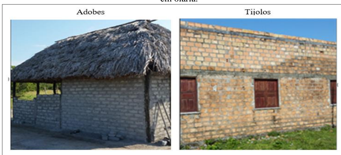
Figura 46 – Casa de adobes produzidos na comunidade e construção de tijolos produzidos em olaria.
