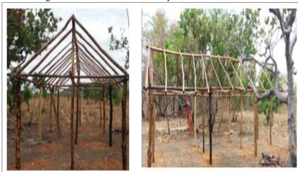
Figura 31 – Moradia em construção: vista frontal e lateral
