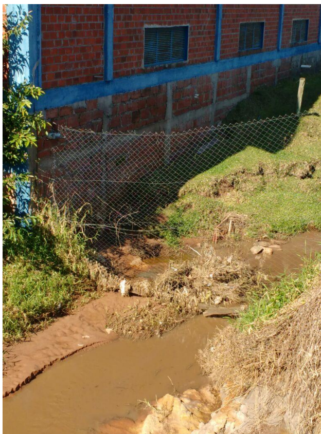
Figura 39 – Ocupação às margens do arroio Funil.
