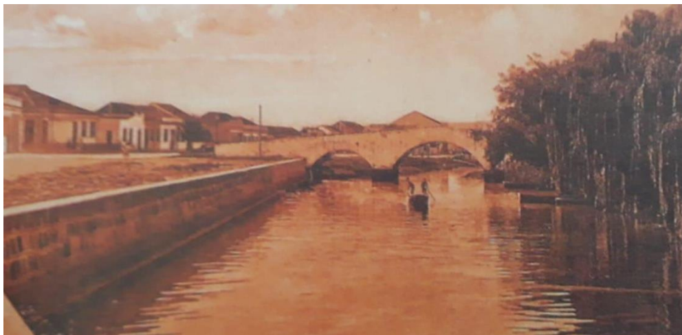
Figura 2 - Ponte de Pedra
