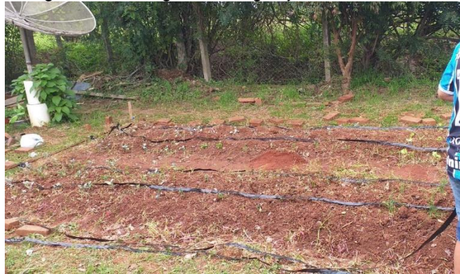
Figura 17 – Mangueiras de gotejamento instaladas
