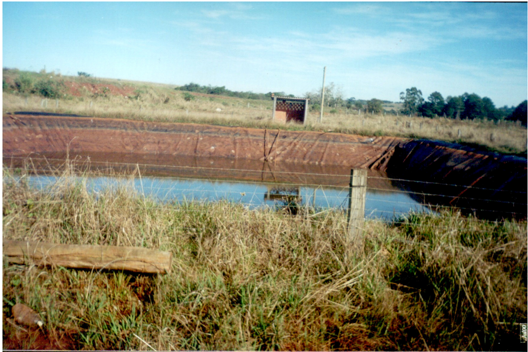
Figura 48: Piscina de decantação dos líquidos provenientes do Aterro.
