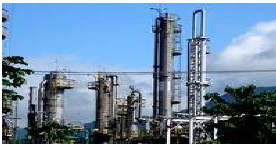
Figura 3. - Torre de fracionamento do petróleo.
